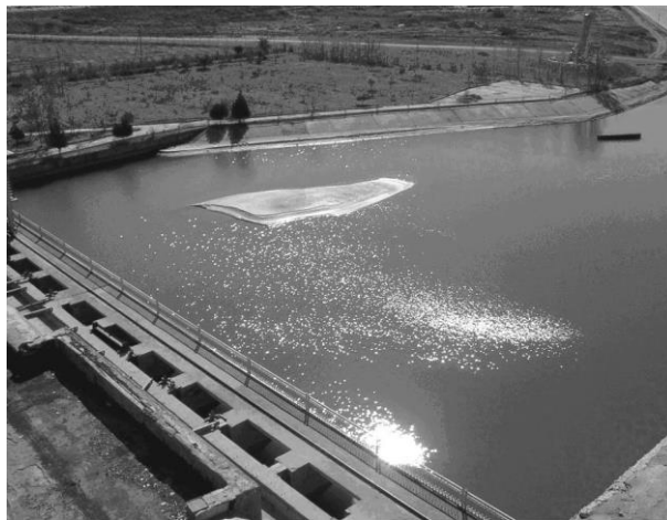
Рисунок 3 – Аванкамера насосной станции № 7 КМК (фото НИИИВП)
