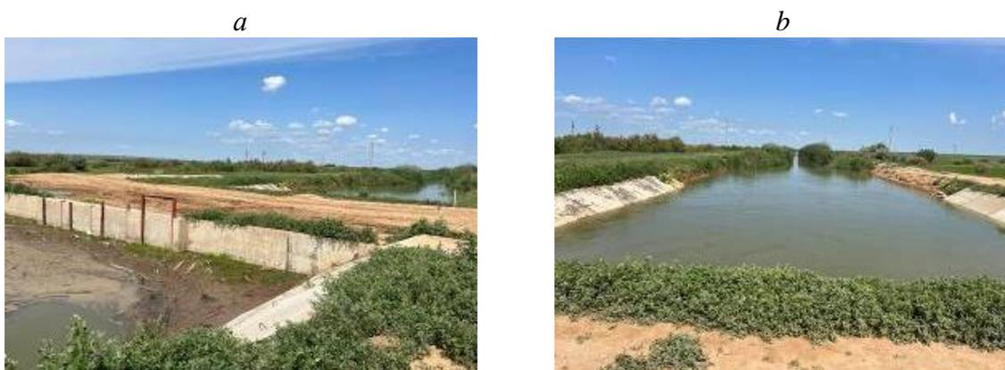
*a* – засорение и заиливание приемной камеры в верхнем бьефе водовыдела на Черноземельском магистральном канале; *b* – нижний бьеф сооружения (Гашунский распределительный канал)
